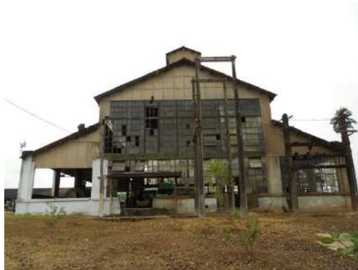
Imagem 1: Vista externa frontal do galpão de força e luz. Foto: Simone Carvalho (2017)
