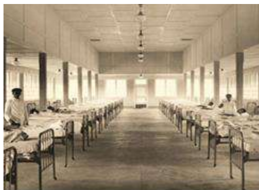
Imagem8: Hospital de Fordlândia década de 30
