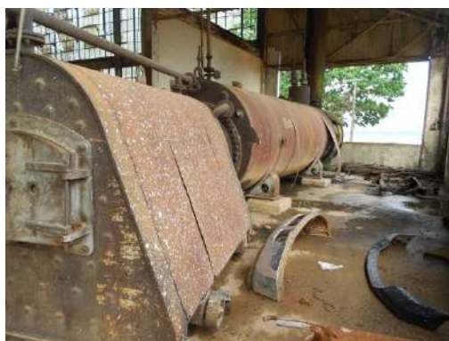
Imagem 2: Caldeira no interior do galpão de força e luz. Foto: Simone Carvalho (2017)
